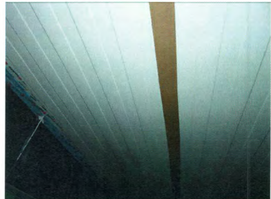
Bild 3 Abklebung der inneren Fugen zur Nullmessung
